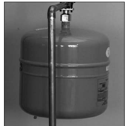
Figure 5 - Un réservoir de dilatation thermique aide à protéger le système de plomberie de votre domicile des pointes de pression.
