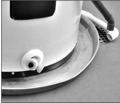
Figure 6 - Un bac de vidange approprié canalisé à un drain adéquat peut aider à protéger le plancher des fuites et des égouttements.
