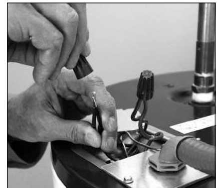
Figure 19 - Connecter les fils électriques.
