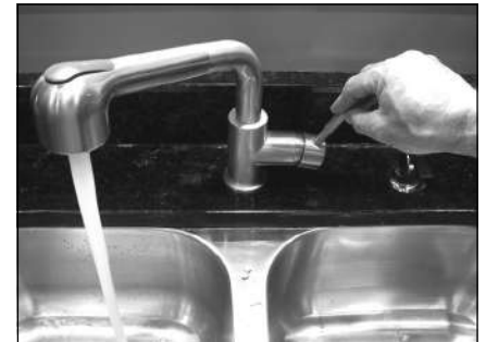
Figure 9 - Laisser l'eau chaude couler jusqu'à ce qu'elle ne soit plus chaude.
