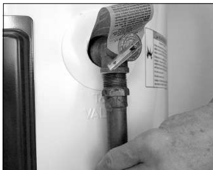
Figure 12 - Le tuyau d'évacuation de la soupape de décharge DST doit être installé correctement et canalisé à un drain adéquat.
