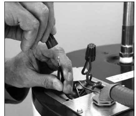
Figure 19 - Connecter les fils électriques.
